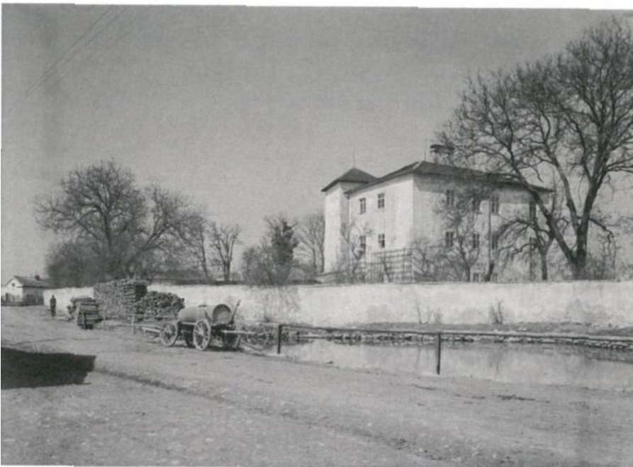
Abb. 61/2 Schloßstraße 28 Ansicht von Südosten, ältere Glasplattenaufnahme; ehem. Dorf- hülle neben der Schlossmauer, Anfang der 1950er im Zuge des Ausbaus der zentralen Wasserversorgung verfüllt (Bayeri- sches Landesamt für Denkmalpfle- ge, Bildarchiv;
