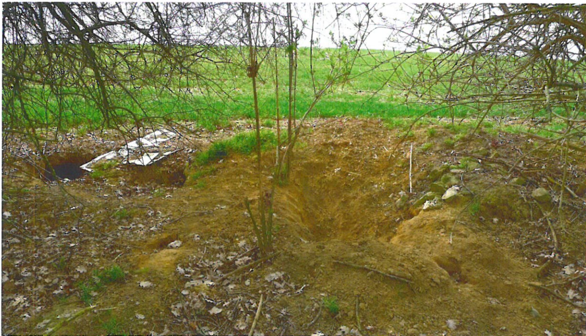
Foto 5: Teilbereich des Dachsbau an der oberen Böschungskante.
